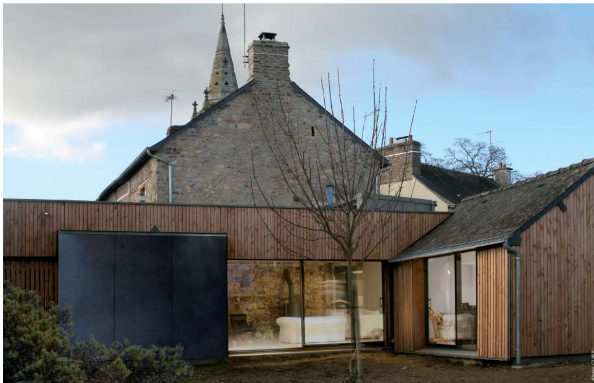
Extension d'une maison (35). © Atelier Cub3. Cet agrandissement en ossature bois d'une maison en pierre, en centre bourg d'un petit village, s'intègre entre la maison et la grange. L'extension est isolée par l'extérieur en fibre de bois, bardage ajouré en douglas naturel. Le maître d'ouvrage : privé. Le maître d'œuvre : Atelier Cub3 (35). L'entreprise bois : Manceau (35).
