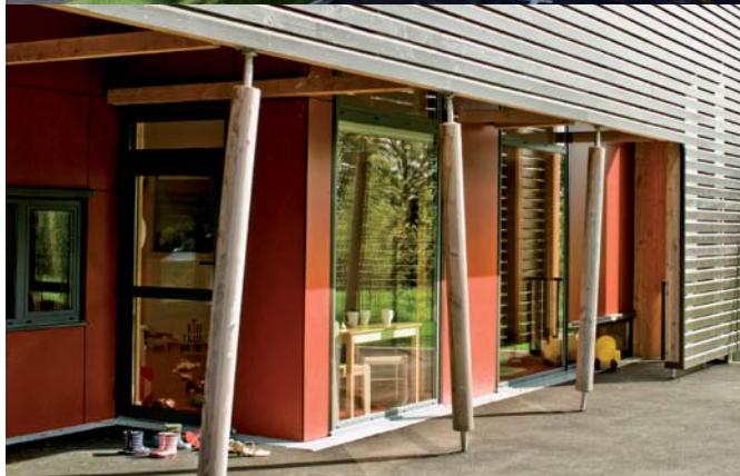
Les deux photos ci-dessus : crèche inter-entreprise. © Balcon Architecte. Ce bâtiment passif de 707 m 2 a été livré en 2010. Le maître d'ouvrage : communauté de communes du Pays de Landerneau et Daoulas (29). Le maître d'œuvre : Patrick Balcon architecte (29). L'entreprise bois : 2MD-Penhoat (29).
