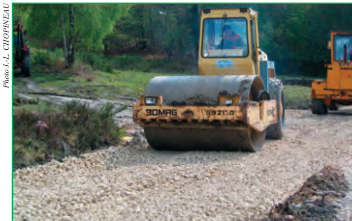
Bien compacter la chaussée avant toute utilisation
