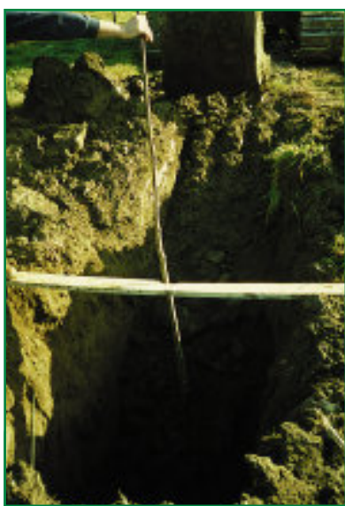
Ouverture des trous de plantation à la pelle mécanique
